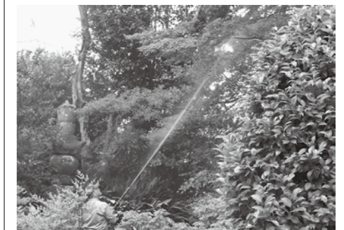
■文化財指定の庭園での施工
