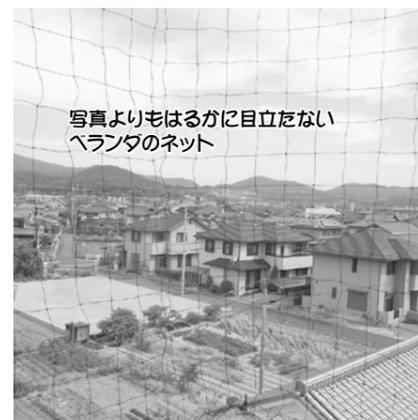
集合住宅のベランダなど、ハトが好んで飛来するエリアを、目立たないネットで覆い、飛来を100%防衛します。壁面に接着させるだけなので、穴をあけるなど建物にストレスが掛かりませんから共同住宅での施工が多い手法です。
