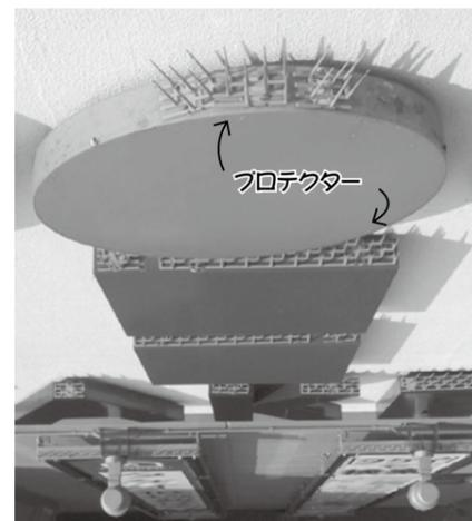
ハトが、継続して飛来して止まる個所に、軽量で、紫外線劣化が少ない特許製品のプロテクターを設置し、飛来できないようにします。
