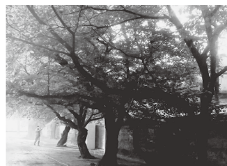
■参道での施工
