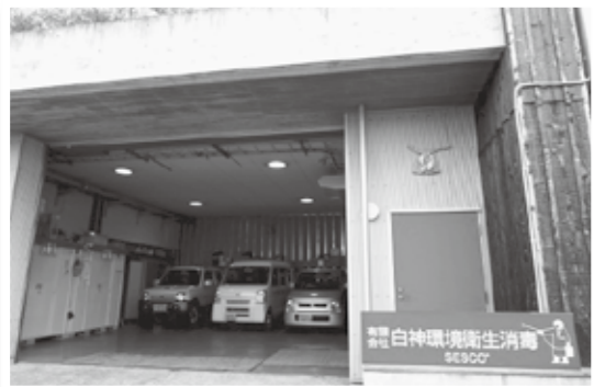
オフィス棟・新倉庫棟の コラージュ (2013年 4月撮影)
