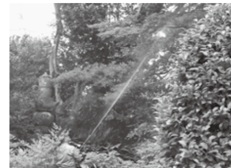
■文化財指定の庭園での施工
